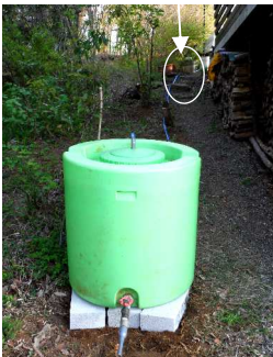
↑畑に置いてあった370ℓタンクを母屋に据え付け、バルブを付ける。上のペール缶で雨水受けホースで下段の貯水タンクへ
