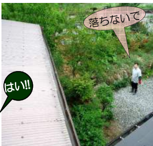
↑05.12新置場兼車庫の雨樋交換3.6m↓屋根の積雪で変形したり壊れたり修理が必要に。
