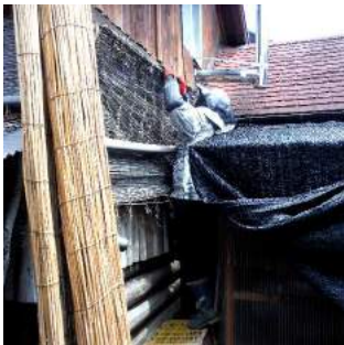
↑05.12梅雨入り前に、カカは日除けのヨシズ交換。トトは貯水タンクを動かし内部清掃。
