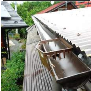
↑05.12新置場兼車庫の雨樋交換3.6m↓屋根の積雪で変形したり壊れたり修理が必要に。
