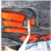
→看板の字をワイヤーブラシで研磨、↑使い古した歯ブラシで塗る
