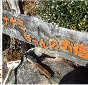
→看板の字をワイヤーブラシで研磨、↑使い古した歯ブラシで塗る
