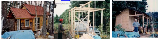
・山小屋、友達の物置新築を手伝い。農機具小屋も建てた。これで定年後はログハウスの建設だ!!...の、はずでしたが?? それでどうなった。なんなのヨ。
