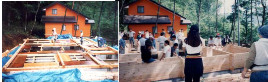
・トトの定年退職後にログハウス建設を目的にキットメーカーの建築体験教室に参加。傷害保険に入って手弁当で山梨県を中心に数カ所、手伝いに行った。
