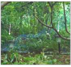
↑07.16破られたネットを補修、ソーラーライトを設けた
