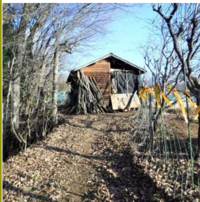
01.08ト トの手作り 農作業小屋 2×4と軸 組みの折衷 建築。→小 屋の中に 戻った管理 機、いつで も耕運OK
