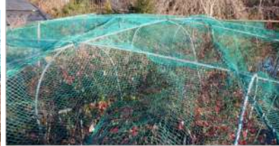
←12.20半月ぶりに作業再開、ネットをつなぎ合わせる ↑細いU字パイプで支えている、積雪には耐えられない。
