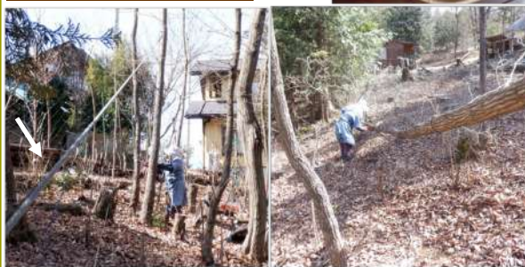
↑03.07裏の林で伐採作業、ワイヤーを張って切る準備。
